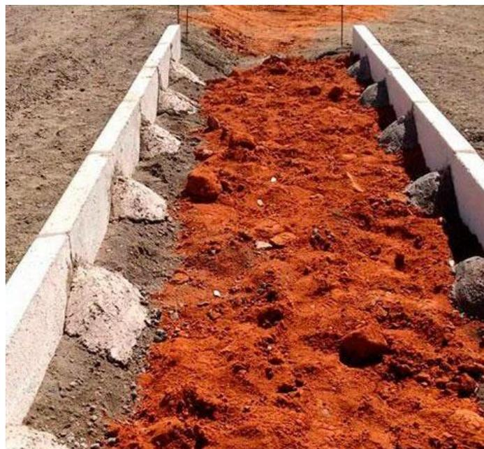
Figura 2 - Exemplo de instalação de mini guia interna
