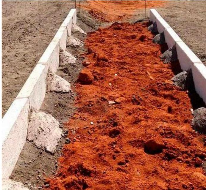
Figura 9 - Exemplo de instalação de mini guia interna
